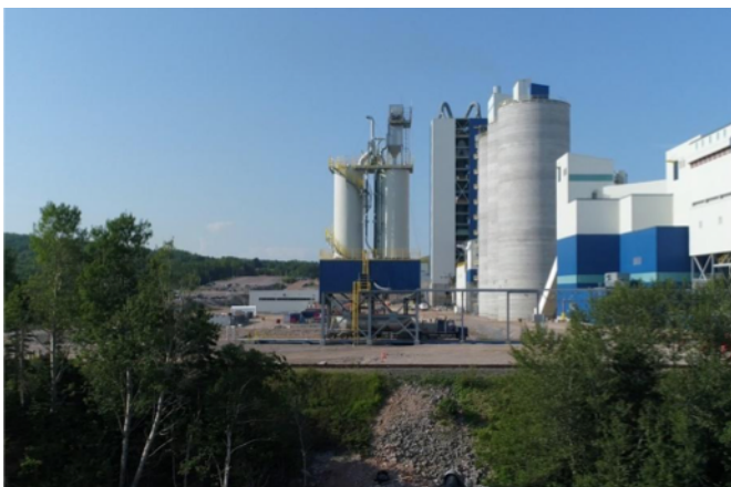
Cimenterie de Port-Daniel
